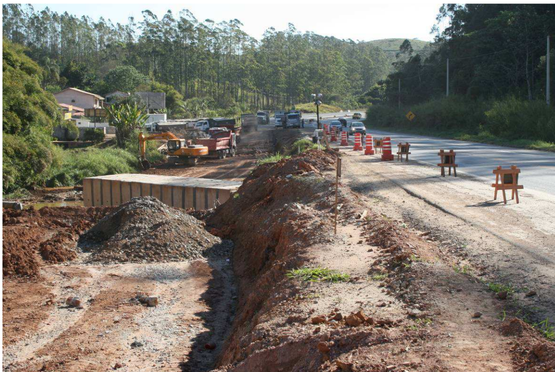
Foto 7 – Construção de galeria - km 14.5
