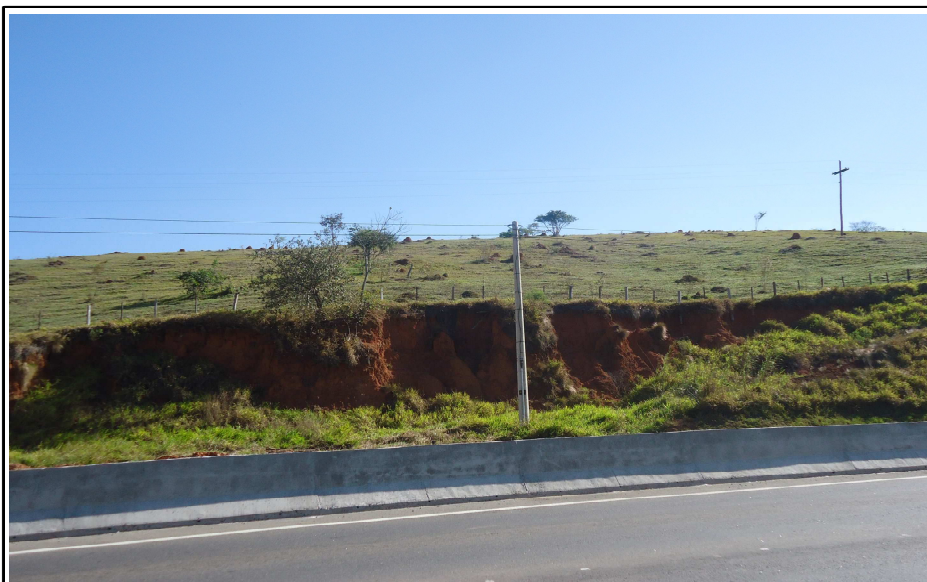
Foto 01- CO-004- Empastilhamento e corrida de massa em talude de corte Falta sistema eficiente de drenagem e revegetação
