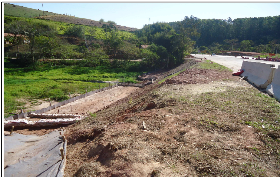
Foto 02- AT-001 - Escorregamento em travessia de drenagem Falta sistema eficiente de drenagem e contenção
