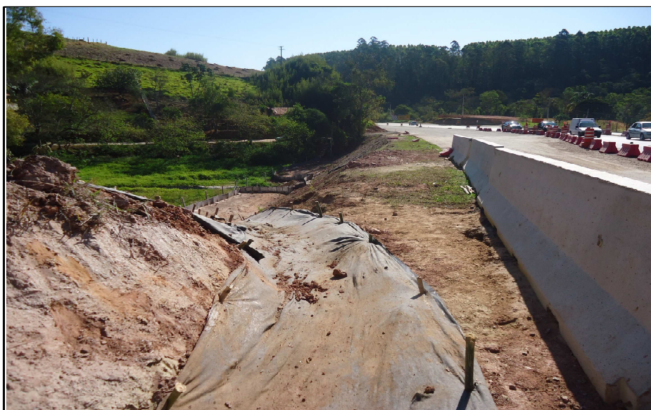
Foto 01- AT-001 - Escorregamento em travessia de drenagem Falta sistema eficiente de drenagem e contenção
