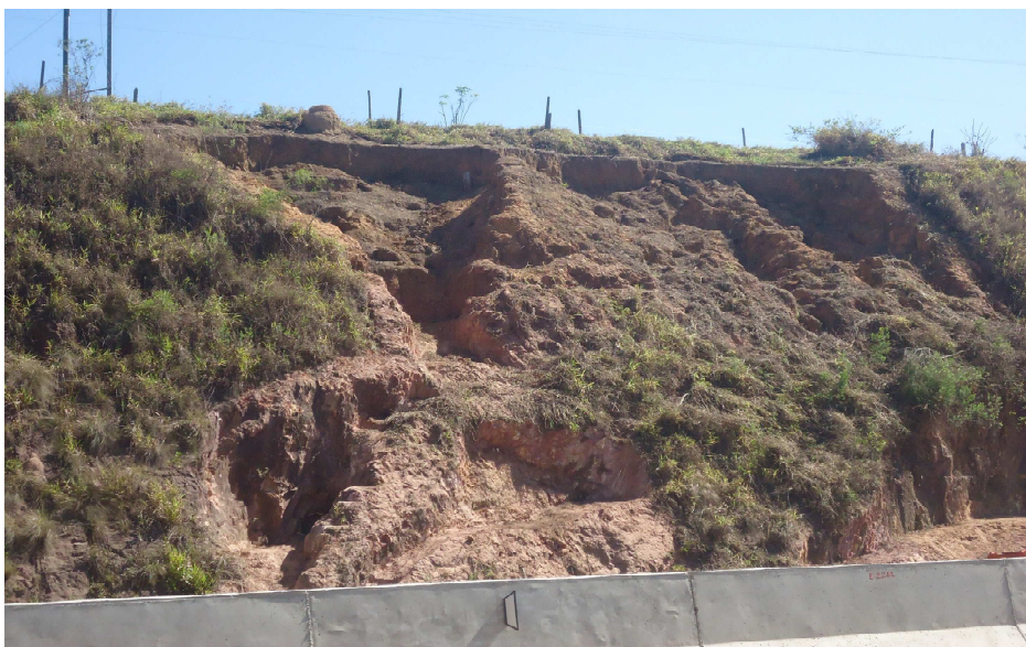
Foto 01- CO-002- Empastilhamento e rastejo em talude de corte Falta sistema eficiente de drenagem e revegetação
