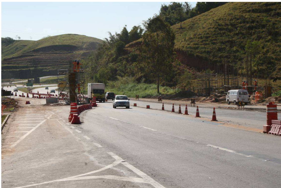
Foto 3 – Obras de duplicação – Construção de P.S. – km 12,0
