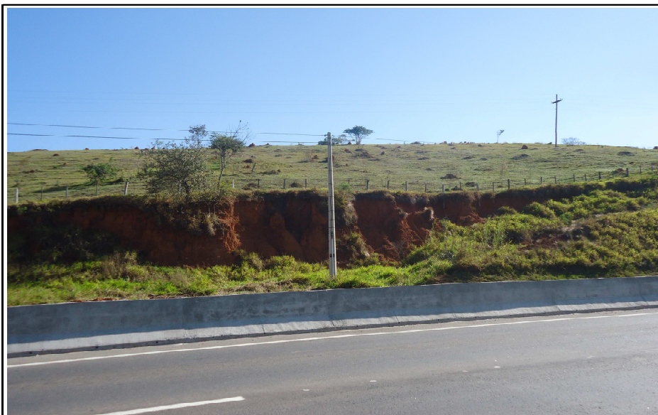
Foto 02- CO-004- Empastilhamento e corrida de massa em talude de corte Falta sistema eficiente de drenagem e revegetação
