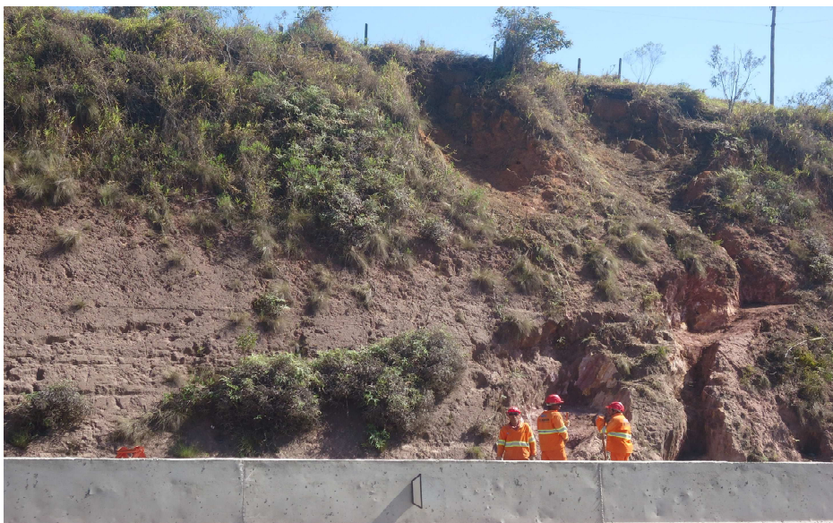
Foto 02- CO-002- Empastilhamento e rastejo em talude de corte Falta sistema eficiente de drenagem e revegetação
